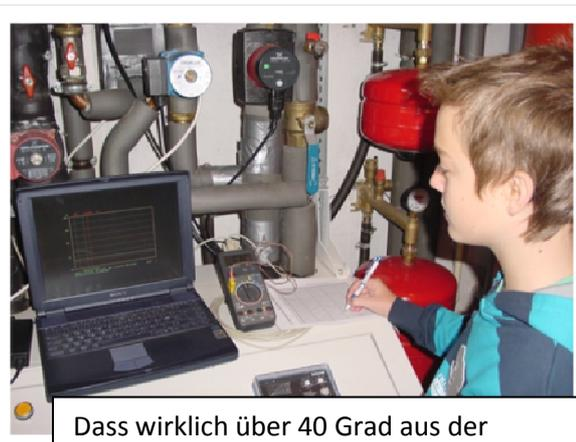
Dass wirklich über 40 Grad aus der Wärmepumpe kommen, überprüfen wir mit einem Temperaturfühler
