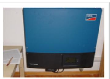
Der Wechselrichter wandelt den Gleichstrom der Solarmodule in 230 V – Wechselstrom zur Einspeisung in das Hausnetz um
